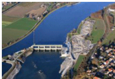
Das Stauwehr mit Wehrkraft links und dem Umgehungsgewässer im Rohbau, Oktober 2009.
