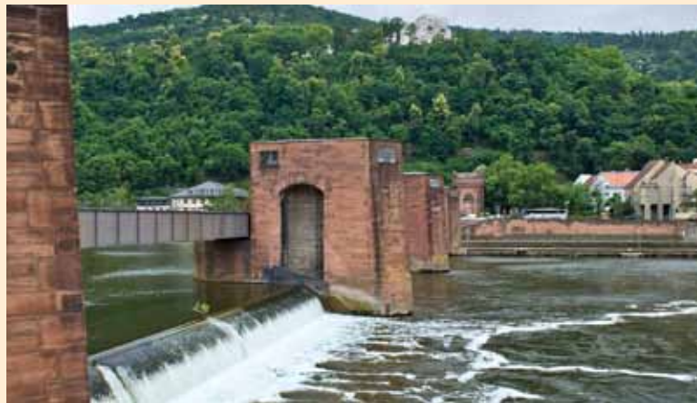
Die im Jahr 2000 eröffnete Wasserkraftanlage Karlstor in Heidelberg ist das zweitjüngste Kraftwerk des Neckars. Es befindet sich unterhalb des Schlosses. Das Besondere und zugleich Kuriose: Es handelt sich um ein Unterwasserkraftwerk.
