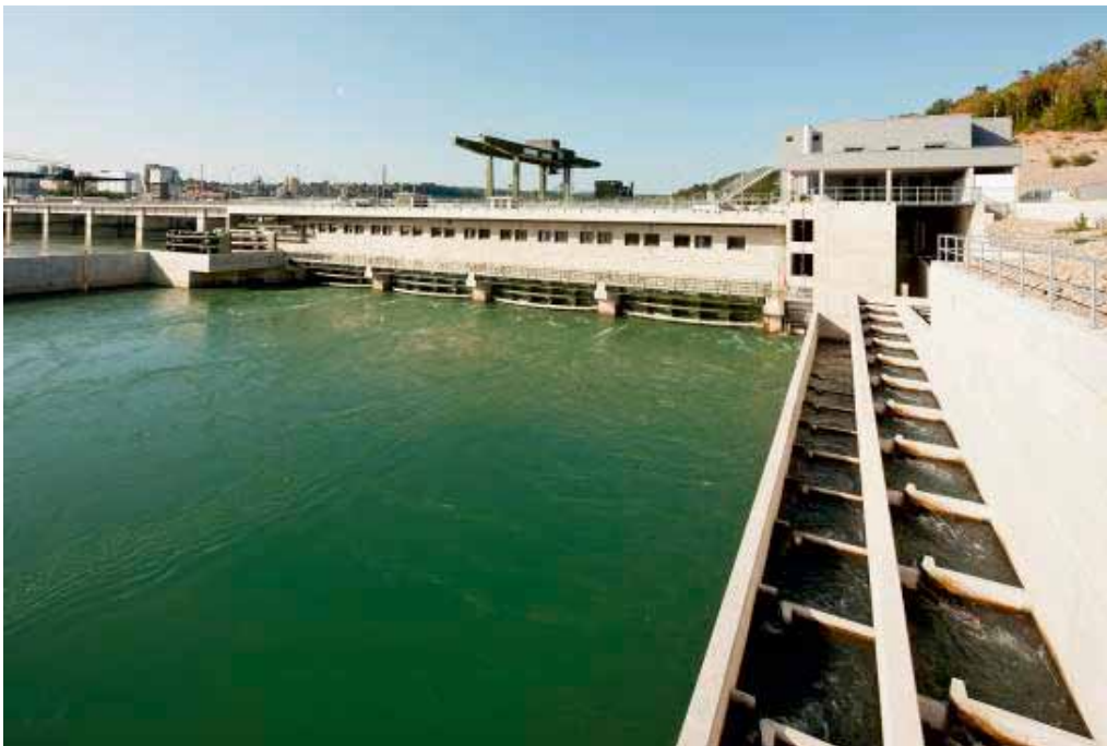
Das neue Wasserkraftwerks Rheinfelden, rechts im Bild der Fischpass. (Quelle: Energiedienst AG)
